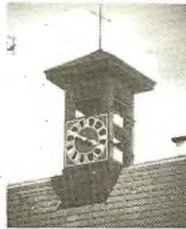
Bild 11: Das Türmchen des einstigen Spitalgebäudes, in dem die beiden Glocken von 1860 hängen.
