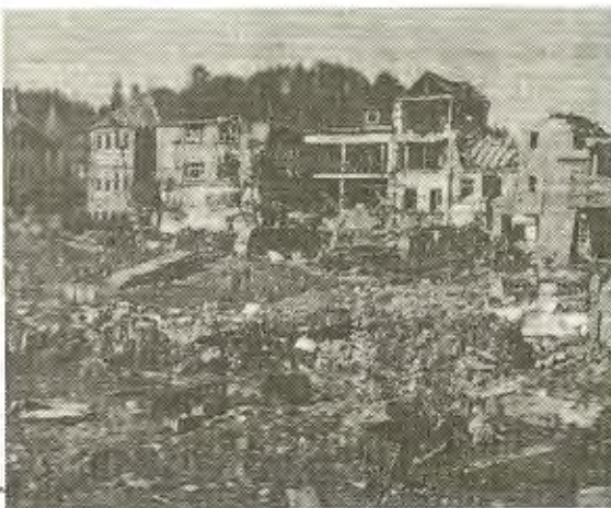
Beim Bombenangriff auf Balingen am 22. Februar 1945 wurde die Trikotwarenfabrik Conzelmann & Co. von etwa 20 Bomben getroffen und in eine Stätte der Verwüstung verwandelt. Von der Vorderfront (siehe Bild) blieb nur ein kleiner Teil stehen. – Das Balinger Bahnhofsgebäude und das Balinger Postamtsgebäude lagen in unmittelbarer Nähe.
