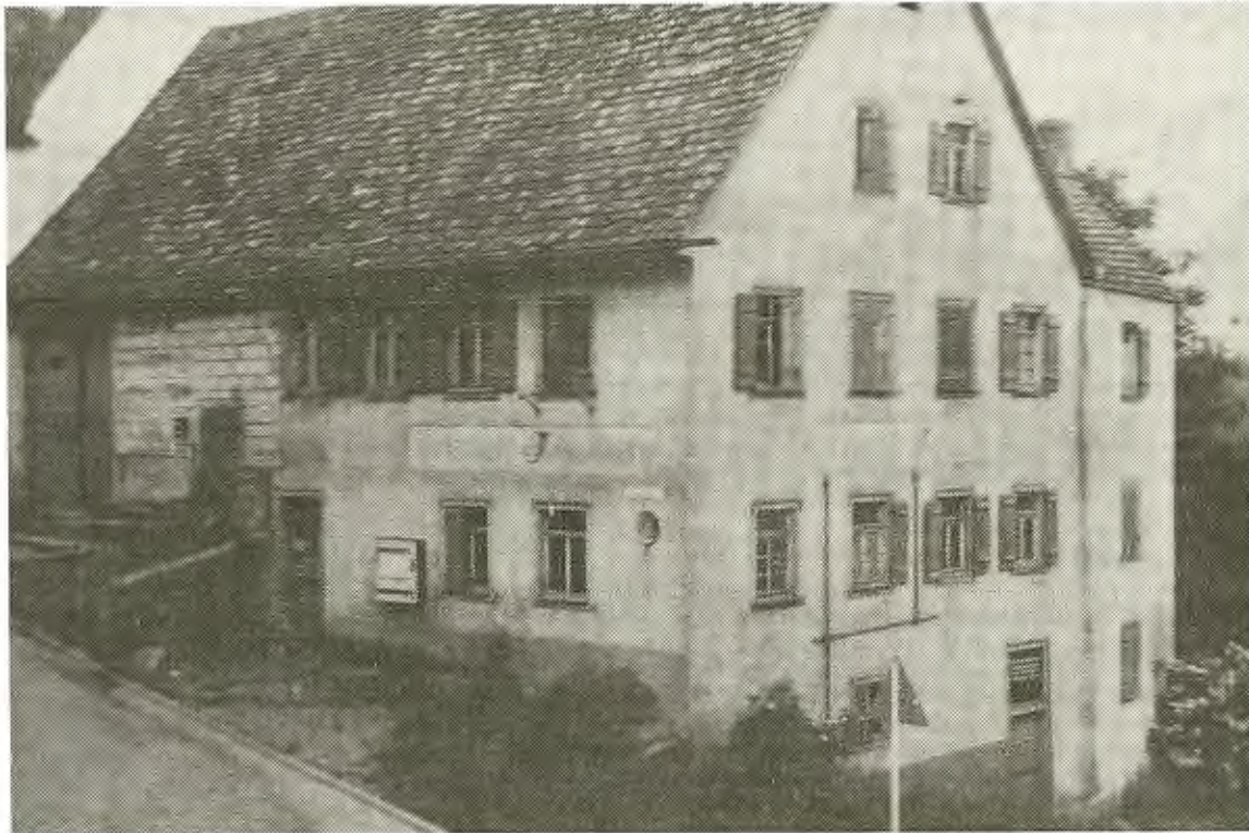
Das „Waldhorn“. Sein Abbruch erfolgte im Sommer 1975.
