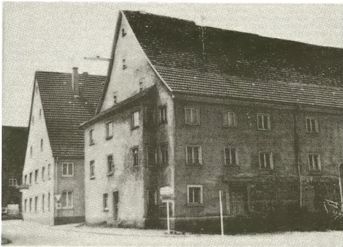
Das Gebäude, in dem sich einst die Wirtschaft „zum Ochsen“ befand, wie es sich in den 70er Jahren darbot. Es wurde gegen Ende 1978 abgebrochen.
